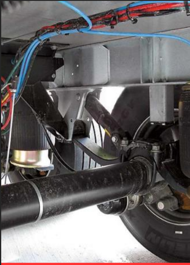
Ремонт воздушной пневмосистемы прицепа и полуприцепа
